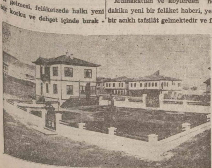
Birçok evleri yıkılan, çatlayan Kırşehirden bir görünüş
